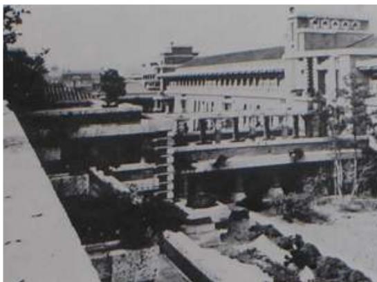
ダイニングルーム屋上より北側のダイニングガーデンを通してブリッジ及び客室を見る。
