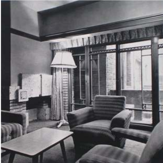
客室の内部。外に見える壁面からするとレセプションルームと思われる。 明石信道著「旧帝国ホテルの実証的研究」より 撮影 村井修
