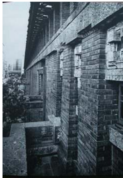
北客室のバルコニーより壁面を見る
