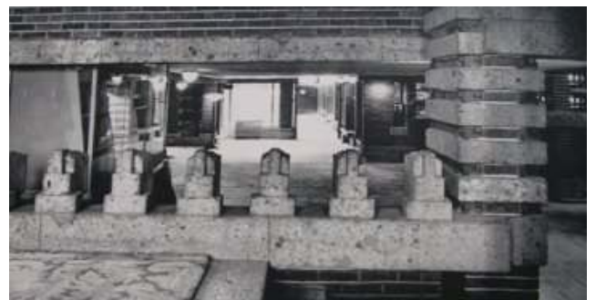
左の写真の手摺子部分の拡大 奥にメインダイニングの側廊が見える
